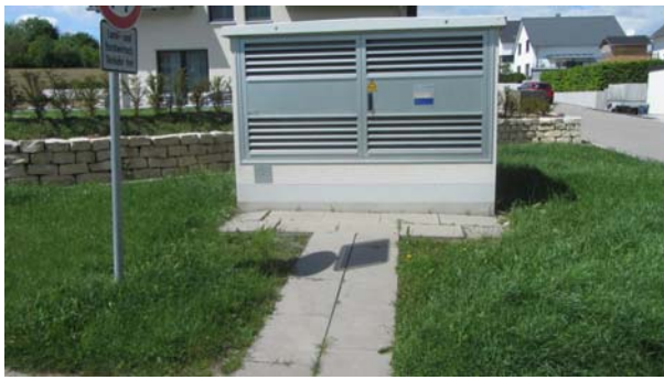
Abb. 14: Umspannstation am südöstlichen Rand des Plangebietes
