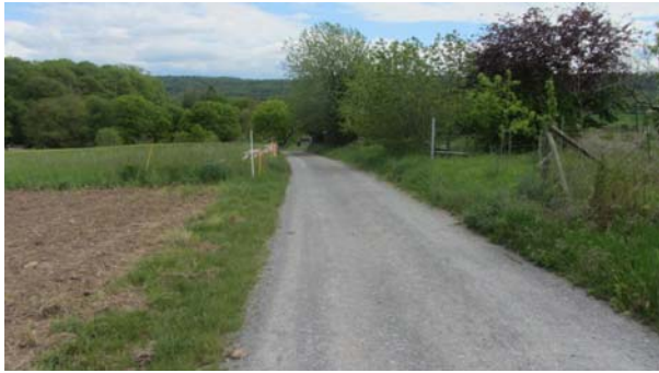
Abb. 7: Wassergebundener Feldweg (60.23) im Westen innerhalb des Plangebietes
