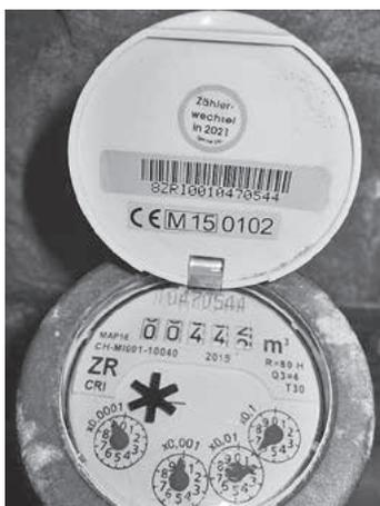
Wasserzählerwechsel wegen Ablauf der Eichzeit: Aufgrund des deutschen Eichgesetzes wird Ihr Wasserzähler routinemäßig alle 6 Jahre gewechselt.
