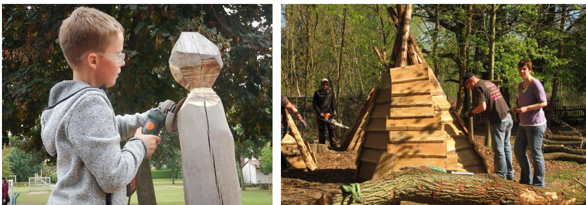
Abbildung 16 - Mitmachbaustellen | Bilder: Stefan Wrobel
