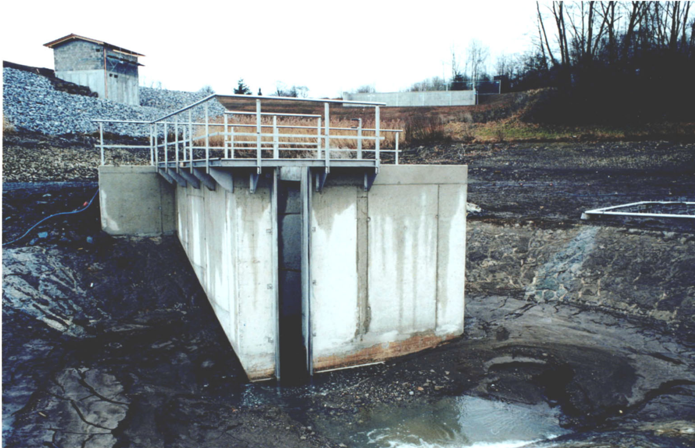
Bild: neues Einlaufbauwerk, 2001
