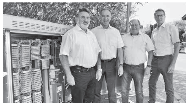
Im Bild die Vertreter der Telekom Volker Ackermann und Martin Stuber mit Bürgermeister Böhringer und Csaszar vor dem neu ausgebauten Kabelzweigler mit Glasfaseranschluss in der Weiterer Straße in Zaberfeld.
